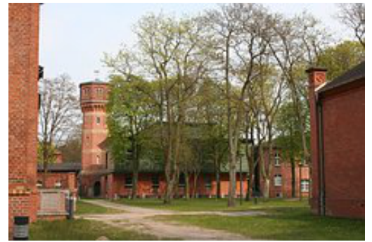
Blick auf den historischen Wasserturm am Haus 2
