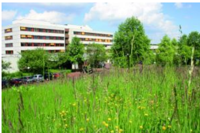
AMEOS Klinikum Osnabrück - Klinikgebäude
