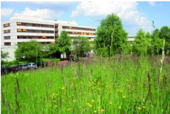
AMEOS Klinikum Osnabrück - Klinikgebäude
